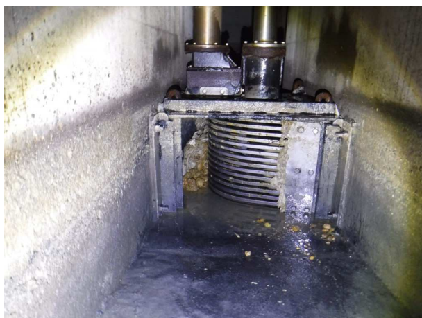
小坪中継ポンプ場内流入水路
