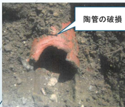
取付管の破損・詰まり (木根による閉塞)
