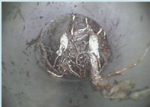
取付管の破損・詰まり (木根による閉塞)
