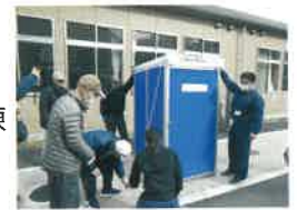
マンホールトイレ設置訓練
