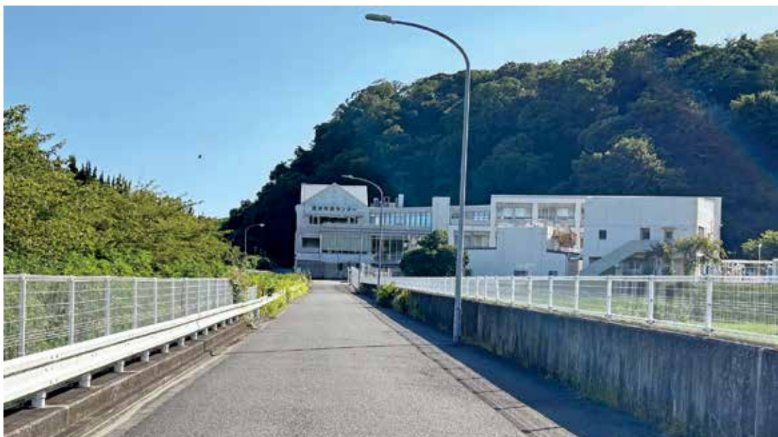
逗葉地域医療センター・逗子市保健センターへの進入路
