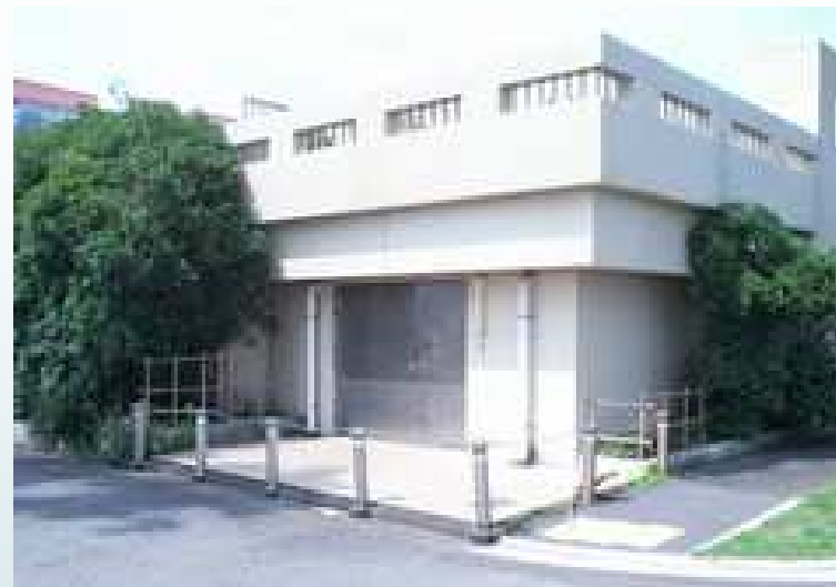
■ 小坪中継ポンプ場
