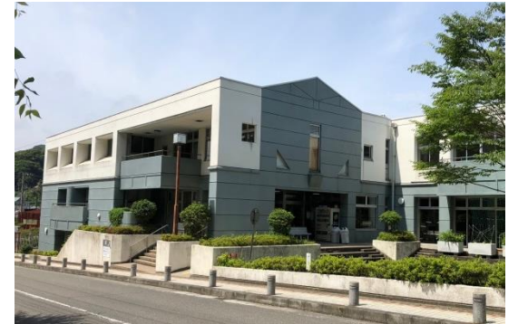
沼間小学校区コミュニティセンター
