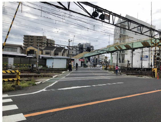
【金沢新道踏切 現況写真】
