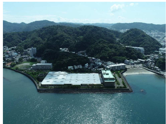
【浄水管理センター 現況写真】
