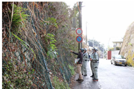
【斜面の定期点検調査】
