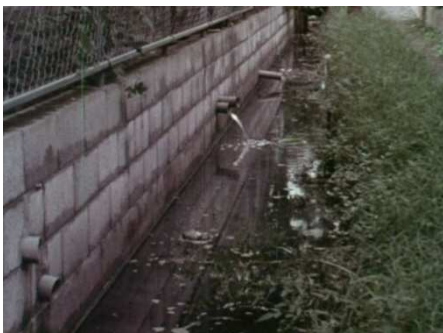
(下水道整備前)
