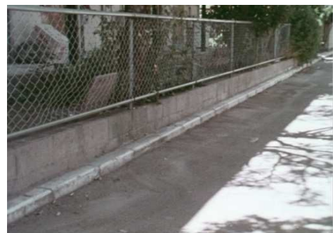
(下水道整備後)
