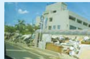
豪雨災害後の岡山県倉敷市真備町
