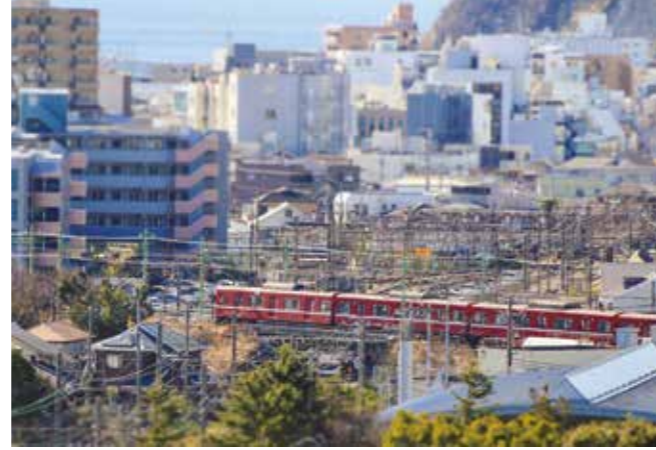
▲池子アザリ工団地から望む京急車両
