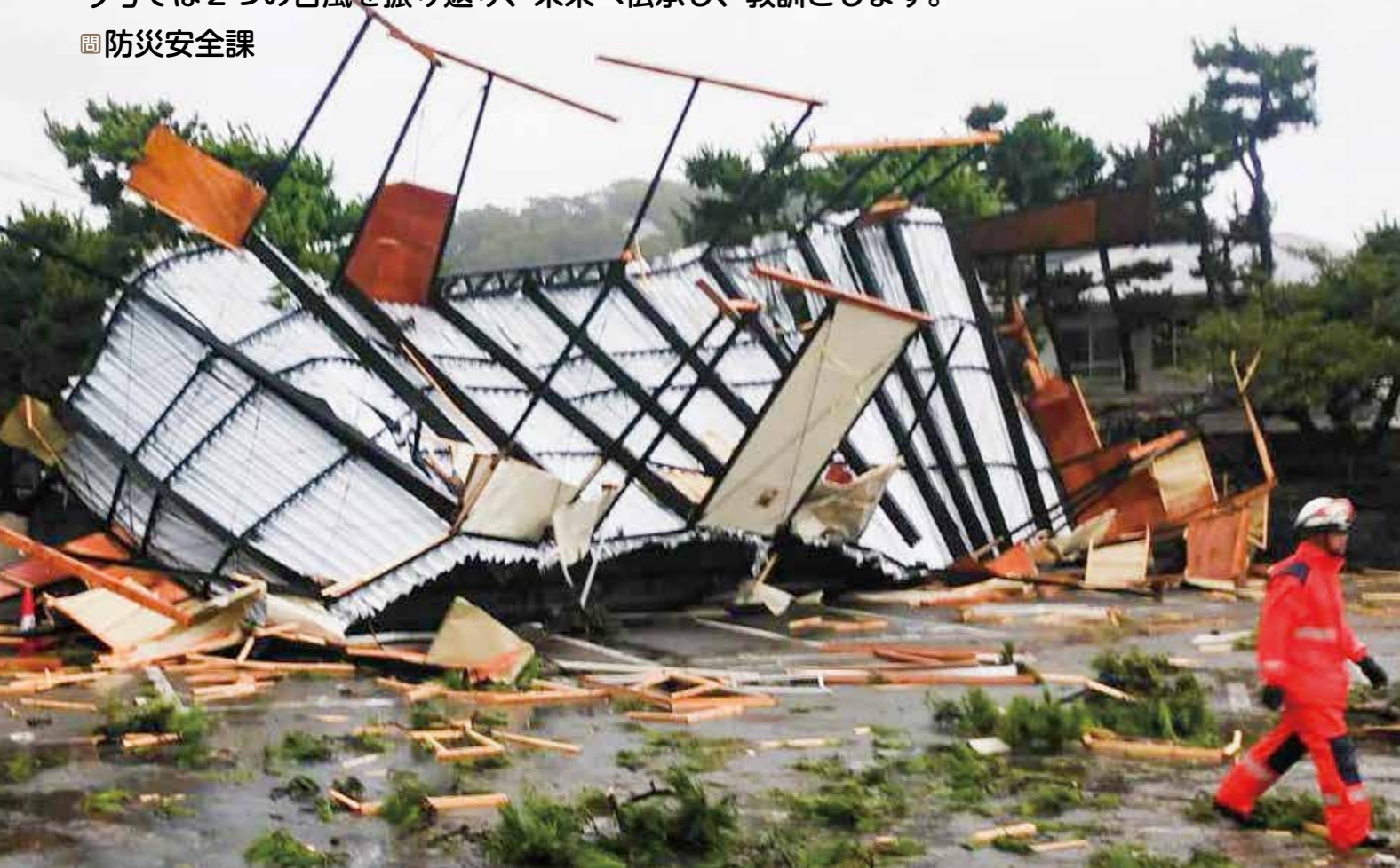
▲暴風で被害を受けた黒門駐車場(新宿1丁目)の屋根(9月9日6:15撮影)
