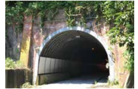
上が小坪隧道、右が名越隧道。入り口にはレンガがあしらわれている。これらは、両トンネルが拡張された昭和4～6年に積まれたものと推測される
