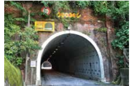
上が小坪隧道、右が名越隧道。入り口にはレンガがあしらわれている。これらは、両トンネルが拡張された昭和4～6年に積まれたものと推測される
