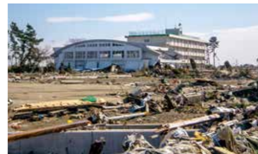
震災直後の 仙台市荒浜 小学校
