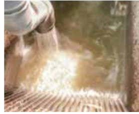
▶浄水管理センターに流れ込む汚水
