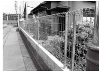
危険ブロック塀の撤去後
