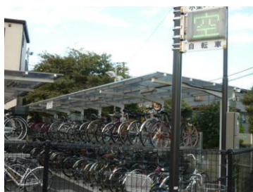
JR逗子駅近くに設置された駐輪場
