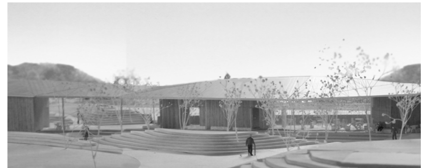
外壁及び外部開口部等の耐久性を向上させる軒の出のある低層建築であり、屋根外壁等のメンテナンスがしやすい。
