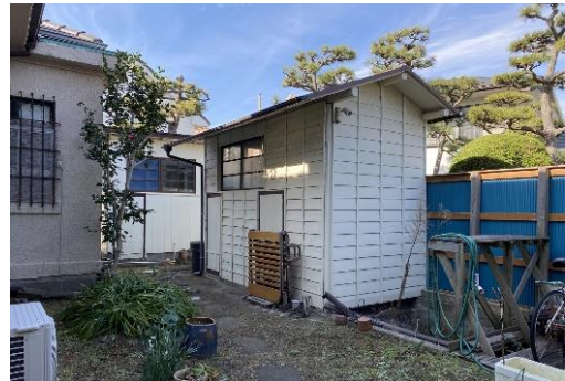
写真②-2 須藤家住宅 旧ボイラー室
