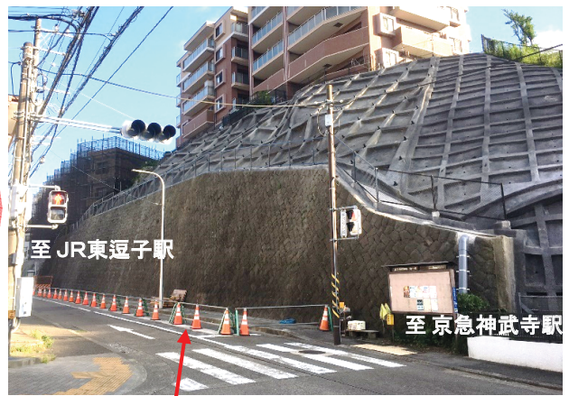
復旧工事完了後の状況写真
