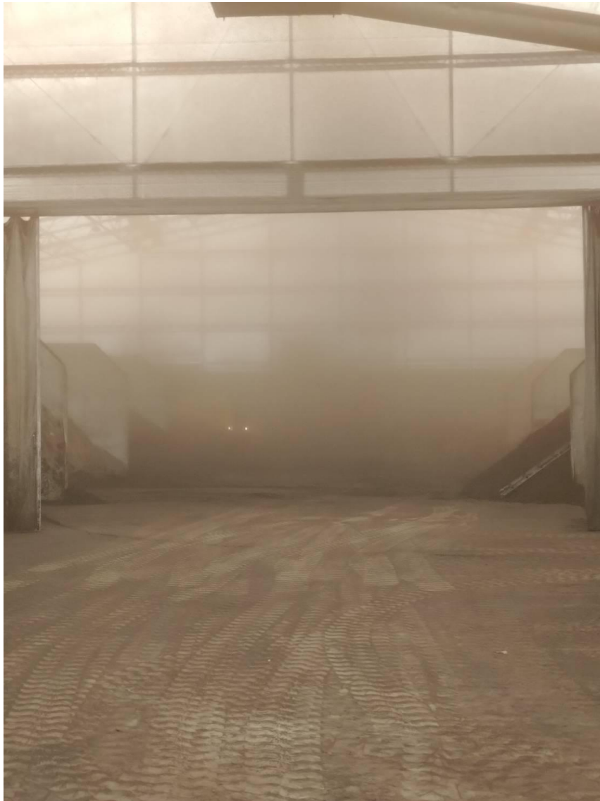
葉山町クリーンセンター「生ごみ資源化処理施設」の町職員の作業中の状況写②
