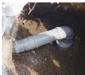
木の根が詰まった下水道管を新しい管に交換
