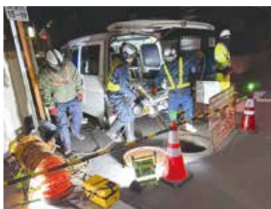
下水道管内のカメラ調査
