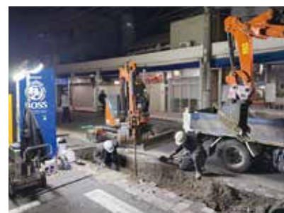
下水道管の耐震化工事
