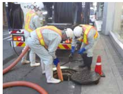
詰まった下水道管の清掃工事
