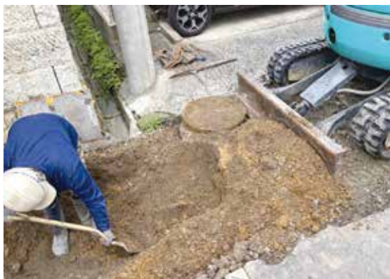
異物が詰まった管を交換する工事
