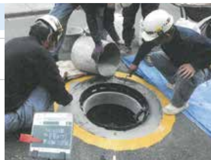
がたつきや破損したマンホールの補修工事
