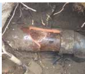
木の根が詰まった下水道管を新しい管に交換
