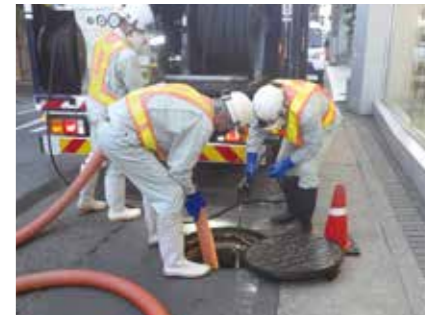
詰まった下水道管の清掃工事
