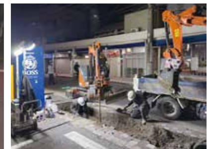
下水道管の耐震化工事
