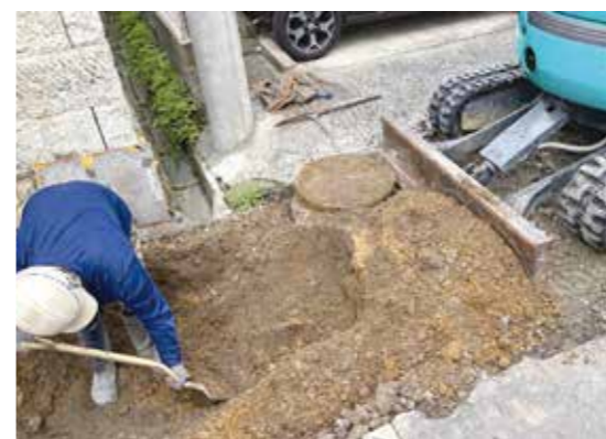
異物が詰まった管を交換する工事
