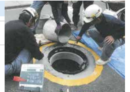
がたつきや破損したマンホールの補修工事
