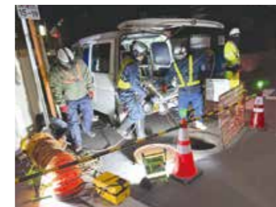
下水道管内のカメラ調査
