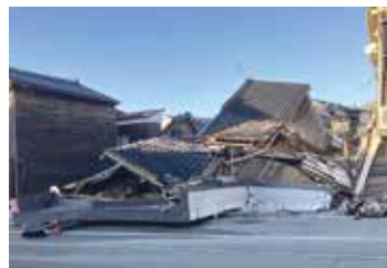
能登半島地震の被害状況▶
