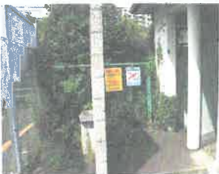
施工前 9月5日 撮影
