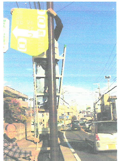
《街路灯にフラッグ取付》
