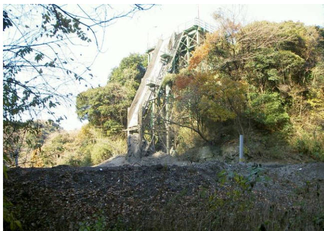
第三期最終処分場
