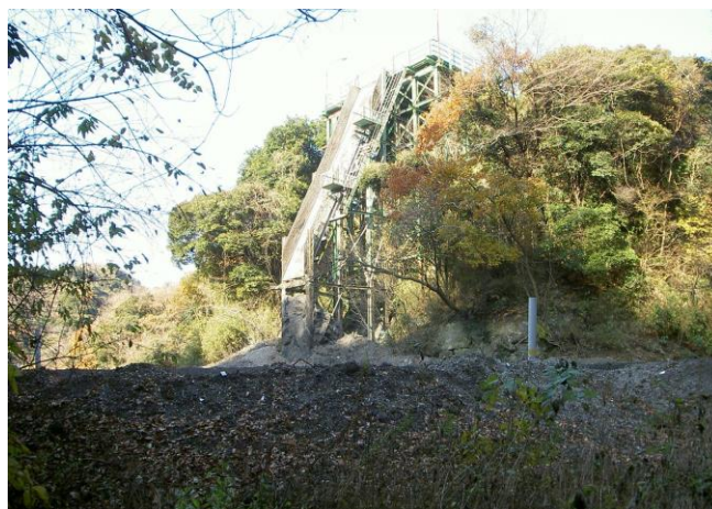
第三期最終処分場
