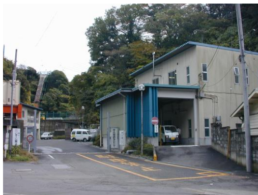
浄化センター
