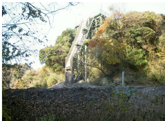
第三期最終処分場
