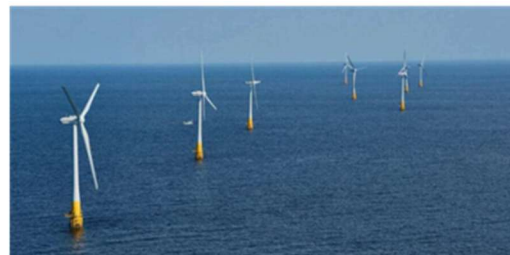
浮体式洋上風力発電*16
