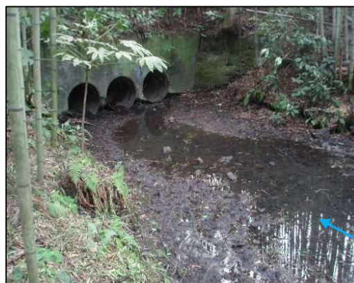
図 3-61 久木池上流の 2 地点を隔てる橋の下のコルゲート管
