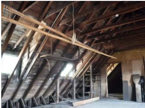
【屋根裏:久米式耐震木骨構造】
