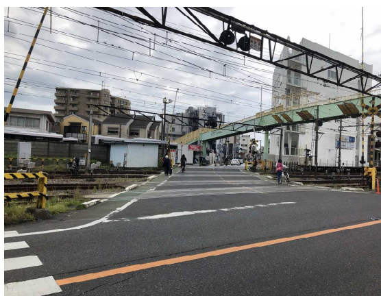
【金沢新道踏切 現況写真】
