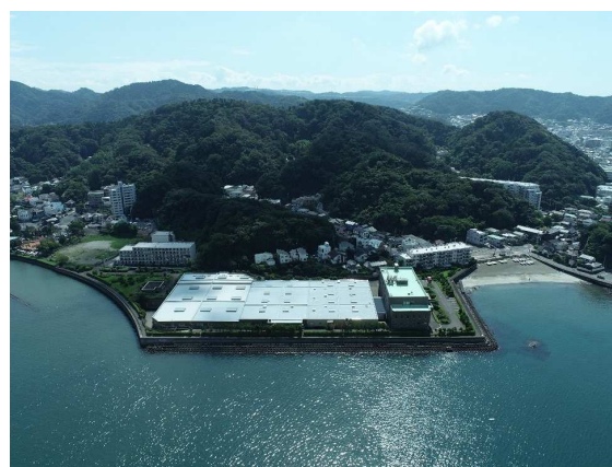
【浄水管理センター 現況写真】
