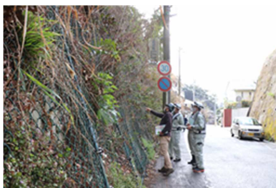
【斜面の定期点検調査】
