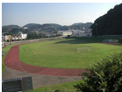
400mトラック兼調整池
