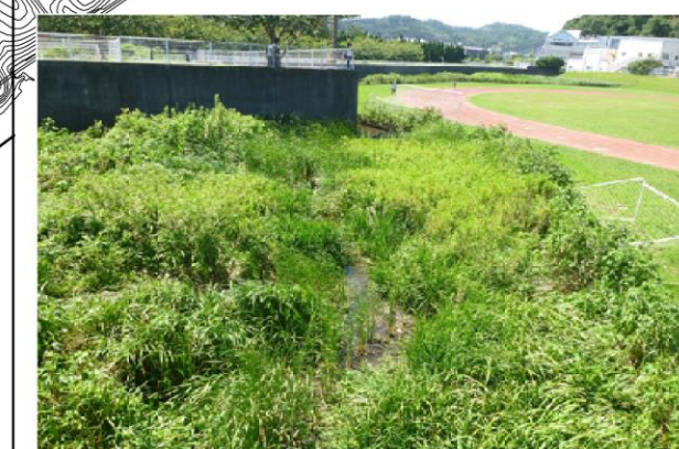
上から見下ろした状況
