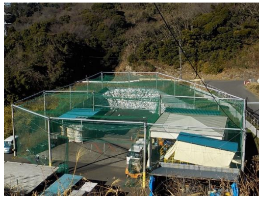
容器包装プラスチック選別処理施設
