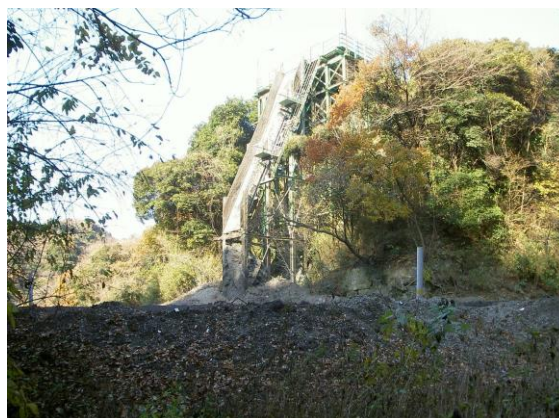
第三期最終処分場
