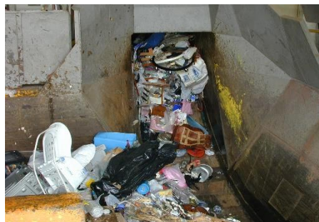
不燃ごみ処理の状況（破碎施設投入口）
