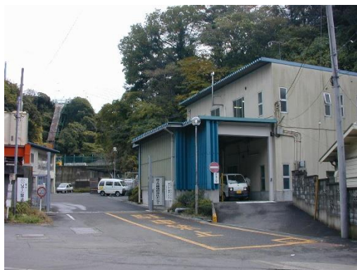
浄化センター
