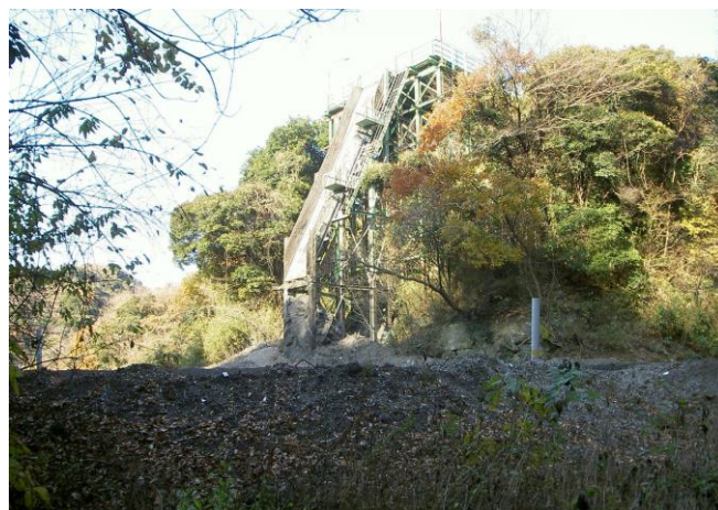
第三期最終処分場
