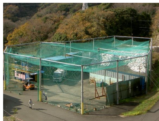
容器包装プラスチック選別処理施設
