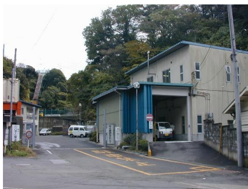
浄化センター
