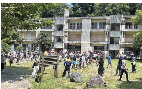
津波避難訓練 待ち望まれる避難所整備
