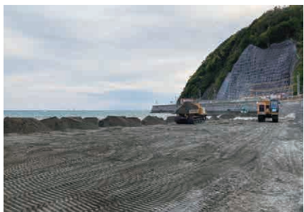
神奈川県が実施している逗子海岸の養浜工事
