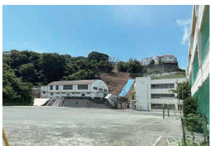
急傾斜地崩壊防止工事
