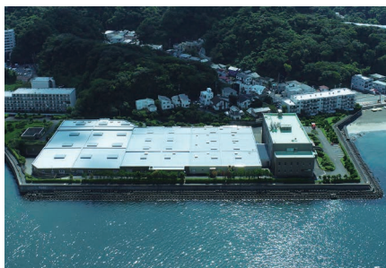
老朽化が進む 浄水管理センター
