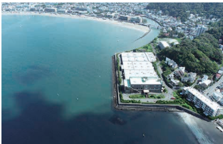
再整備予定の浄水管理センター
