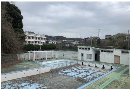
沼間小学校のブルーカーボン太陽光発電付きの学童保育施設が移転・建築されます。
