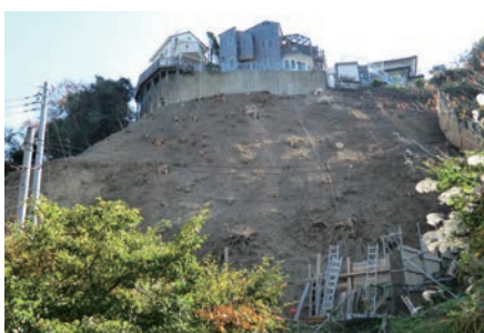
小坪3丁目急傾斜地 崩壊対策工事
