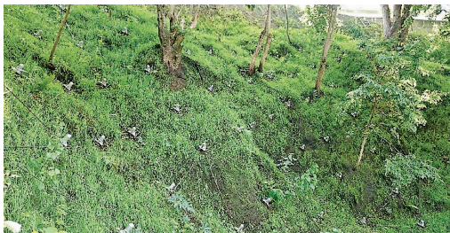
崖地安全対策：施工後1年経った緑再生工法
