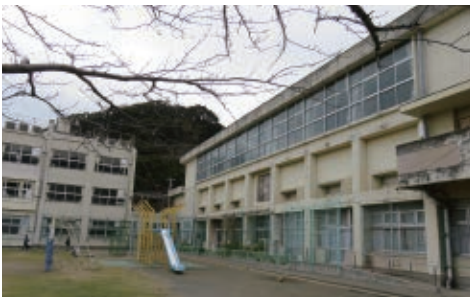
老朽化が進む学校施設
