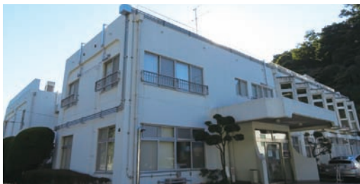
浴場廃止が問題になっている高齢者センター
