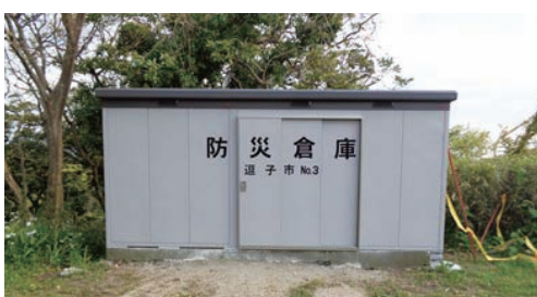
防災倉庫（資機材等備蓄）
