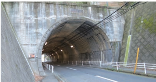
神武寺トンネル、拡幅工事へ
