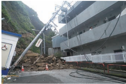
小坪海岸トンネル崩落事故現場
