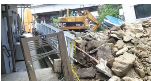
小坪海岸トンネル前の民家に押し寄せた岩石
