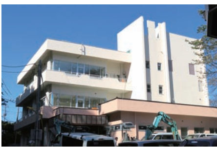
12月開設予定 こども発達支援センター（工事中）
